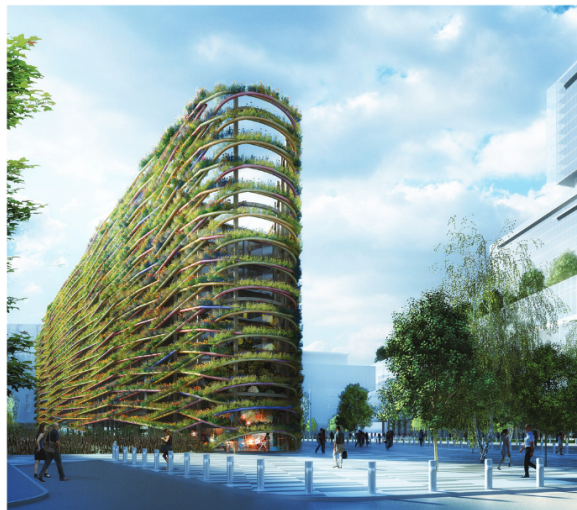
↑ À Paris-Batignolles : un bâtiment autonome pour ses besoins en eau de 4 000 m 3 grâce à une gouttière filtrante et végétale.
