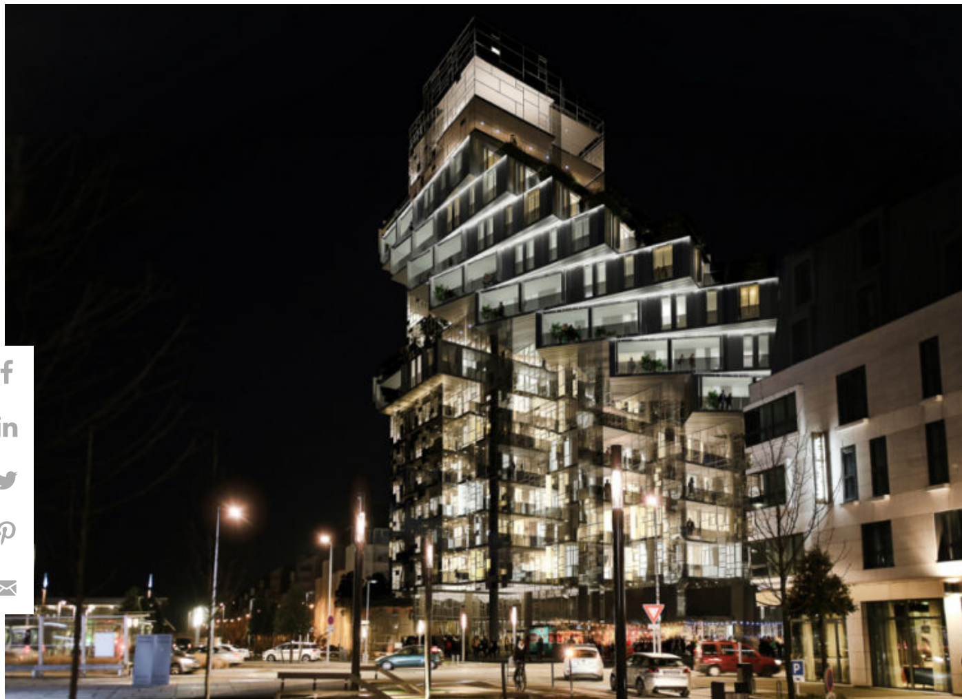
Logements à Saint-Malo @ Loci Anima
